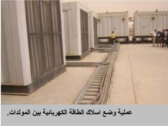
عملية وضع اسلاك الطاقة الكهربائية بين المولدات.
