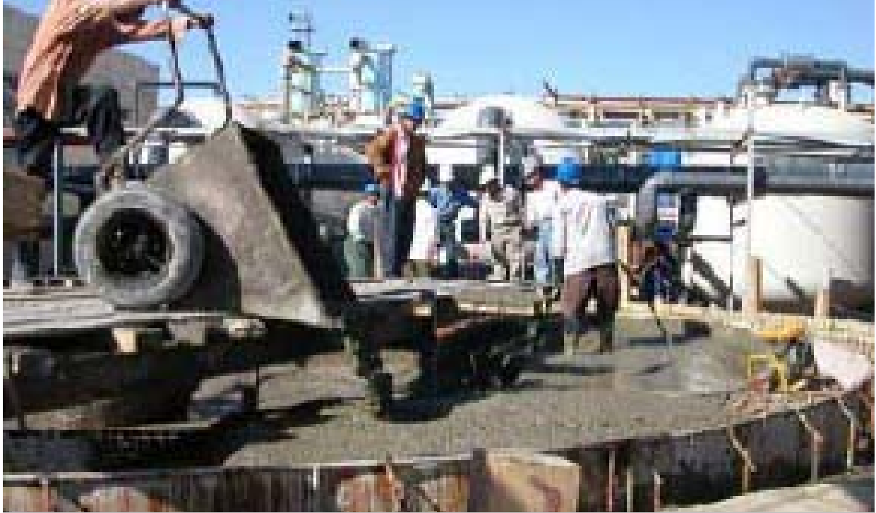
عمال يقومون بوضع الاساس الاسمنتي لمصافي الماء في احد مشاريع الطاقة الكهربائية خارج مدينة البصرة.
