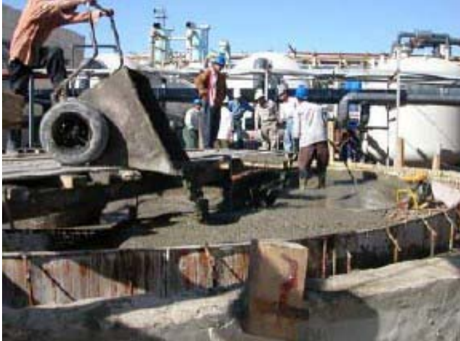
عمال يقومون بوضع الاساس الاسمنتي لمصافي الماء في احد مشاريع الطاقة الكهربائية خارج مدينة البصرة ، وستقوم اقسام معالجة الماء بتحسين الكفاءة والامكانية لخدمات توفير الطاقة الكهربائية في البصرة.
