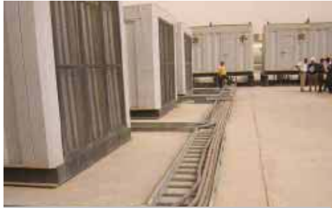
عملية وضع الاسلاك الكهربائية بين المولدات.
