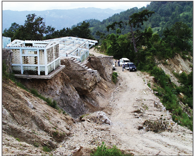
Figura 6. Vista del desprendimiento de tierra El Pinar y de la escuela abandonada. Se regularizó la pendiente de un nuevo camino que pasa por la punta del desprendimiento de tierra, el cual se deslizó hacia el valle del Río La Palma o Las Pozos, a la derecha. Es muy probable que los futuros desplazamientos del desprendimiento de tierra destruyan este nuevo camino.
