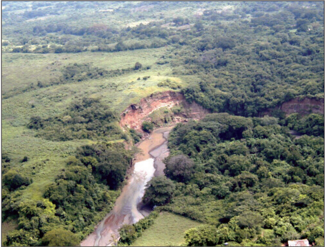
Figura 18. Falla en la ribera del Río Gualcho, unos 4 km corriente arriba del Embalse 15 de Septiembre. Es probable que esta falla y otras similares producidas a lo largo del Río Gualcho hayan sido producto de la acelerada erosión ocasionada por el gran caudal provocado por el huracán Mitch.
