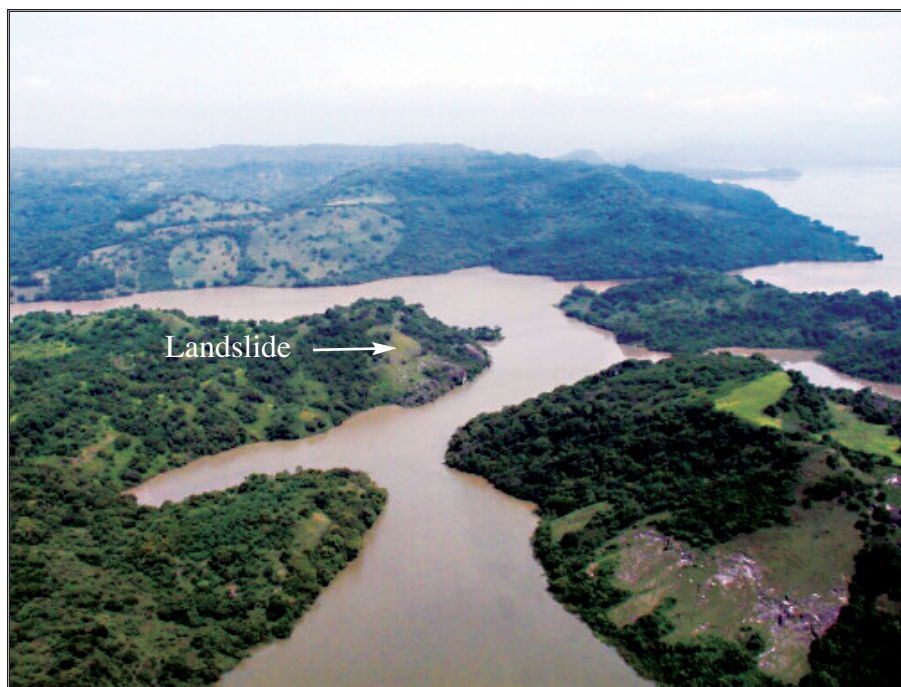
Figura 17. Desprendimiento de tierra superficial en la ribera del Embalse 15 de septiembre. Cuando se tomó esta fotografía en septiembre de 2001, la grieta estaba casi totalmente cubierta de vegetación.
