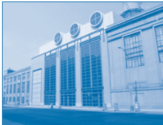
MIT Cogen Facility
