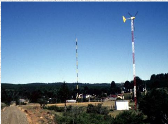
7-kW Turbine in Villa Las Araucarias
