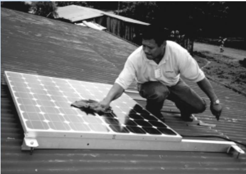
Figura 2.2 Un técnico fotovoltaico limpia dos paneles de 80 vatios que alimenta un refrigerador de vacuna solar en la comunidad de Mulukuku, Nicaragua.
