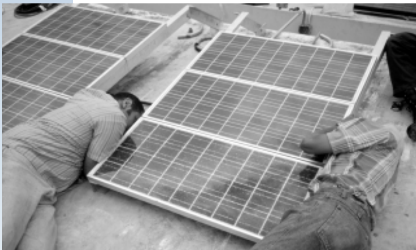
Figura 5.3. Técnicos instalan paneles fotovoltaicos en el techo de la Clínica El Molino, cerca de Trujillo, Perú.
