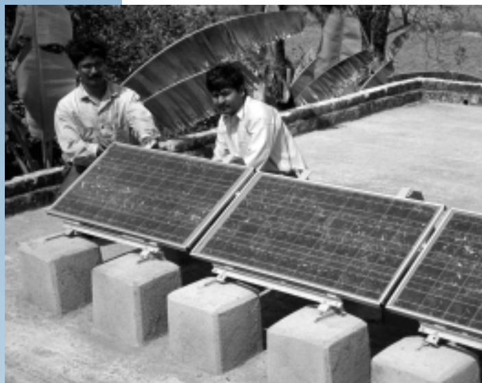
Figura 4.2. Técnicos instalan módulos fotovoltaico en una clínica de villa en Bengala Occidental, India.
