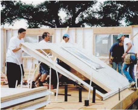
外壁パネル加工に樹脂窓取り付け済みパネル
