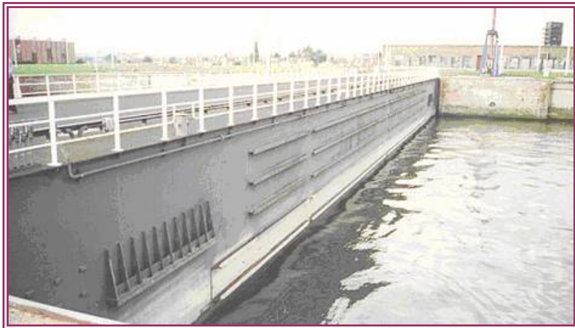
FIGURA 2-7: COMPUERTA DESLIZANTE EN LA ESCLUSA DE BERENDRECHT
