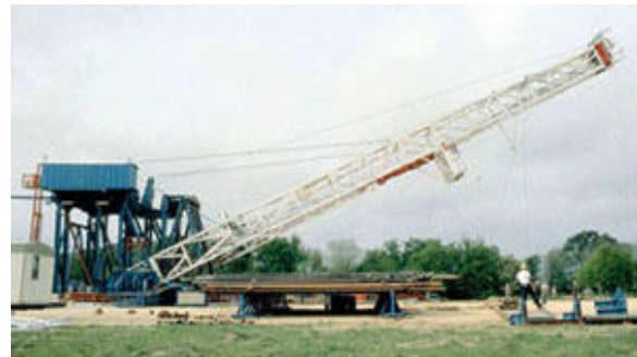
Fig. 1. Hoisting the mast
