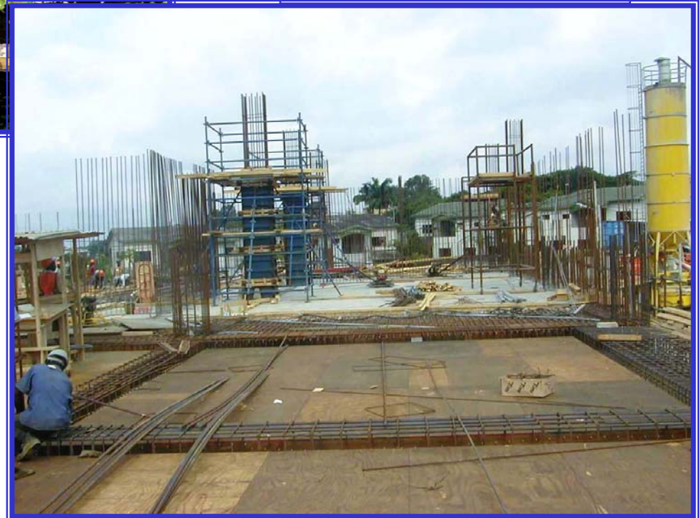
Construction photos of Abidjan, Cote d'Ivoire NEC 39% Complete
