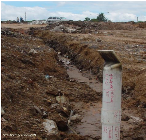
Preparando el terreno para medir la cantidad y calidad del gas metano que genera el relleno.
