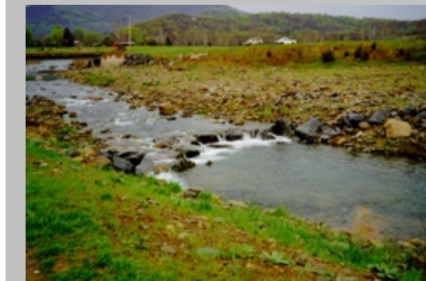
Fig. 2.3-11 Rock weir, Rose River, VA
