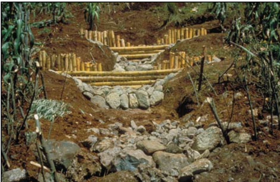
Foto 14.4 Construya las estructuras de retención de escombros y estabilización de quebradas (por ejemplo, presa o diques) con un vertedero para mantener el flujo por encima de la parte media de la estructura, coloque protección a la salida de cada estructura y ancle las estructuras en las márgenes de suelo firme.
