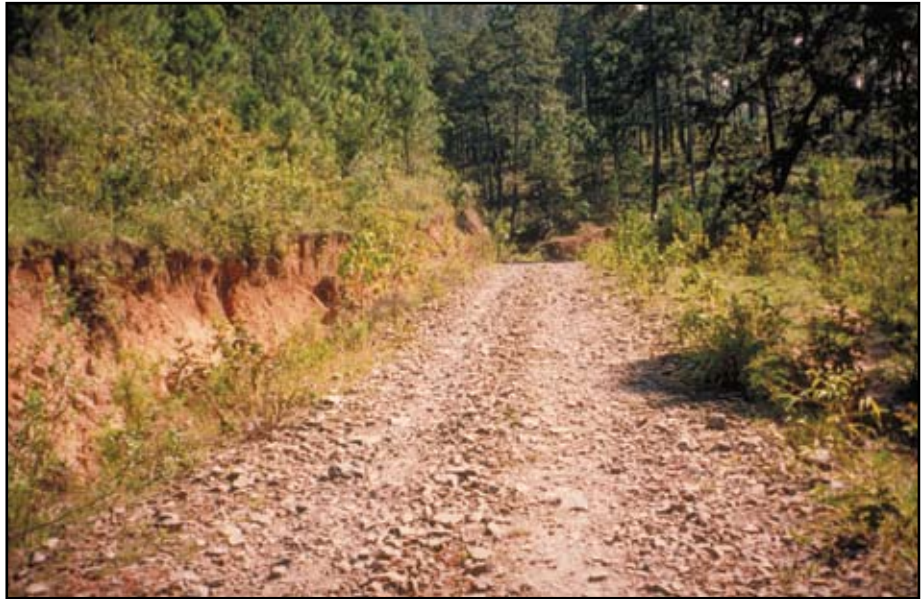
Foto 12.2 Estabilice la superficie de la calzada con roca triturada (o con otro tipo de revestimiento) en pendientes empinadas, zonas con suelos blandos o erosionables.
