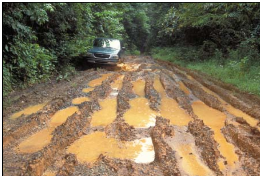
Foto 4.8 Evite las actividades de construcción y de otro tipo durante las temporadas de lluvia siempre que sea posible. Alternativamente, añada estabilización de la superficie y del drenaje en zonas de suelos pobres o blandos, para su uso en cualquier tipo de clima.
