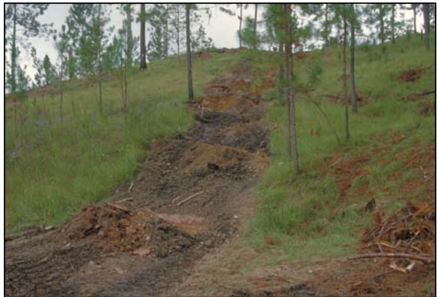
Foto 3.8 Estabilice los caminos y senderos de arrastre de troncos después de concluir su uso, mediante caballones desviadores y aplique cubiertas de vegetación u otros tipos de medidas para el control de la erosión.
