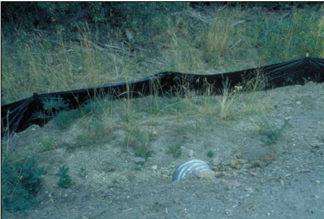
Foto 6.6 Uso de geotextiles como “barreras contra azolves” para atrapar sedimentos de una zona en construcción.
