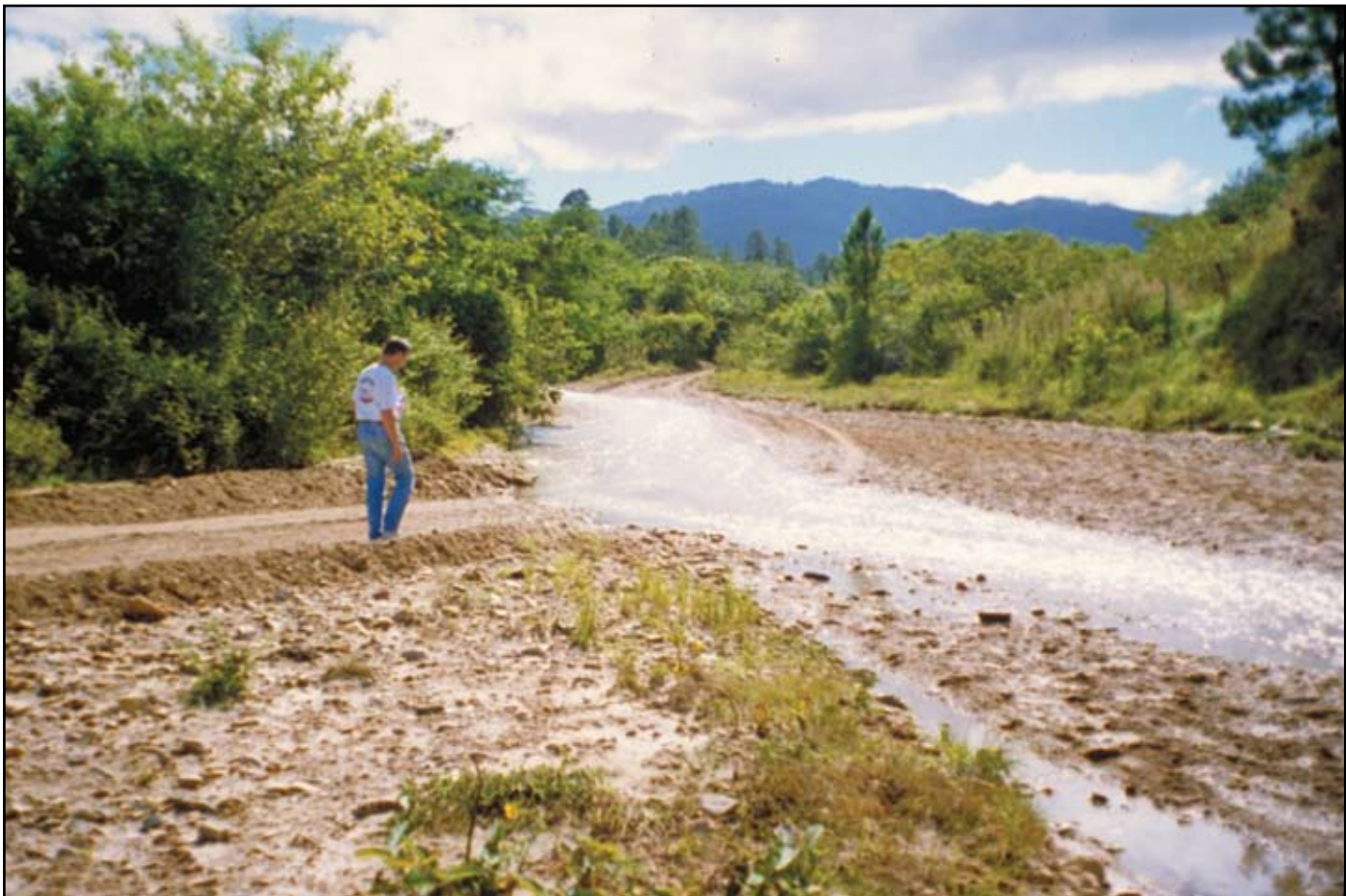
Foto 7.8 Evite cruces del drenaje natural que sean anchos y que no sean perpendiculares al drenaje. ¡Aléjese del arroyo! Este canal ancho es un buen sitio para un vado simple o un vado mejorado con alcantarillas.
