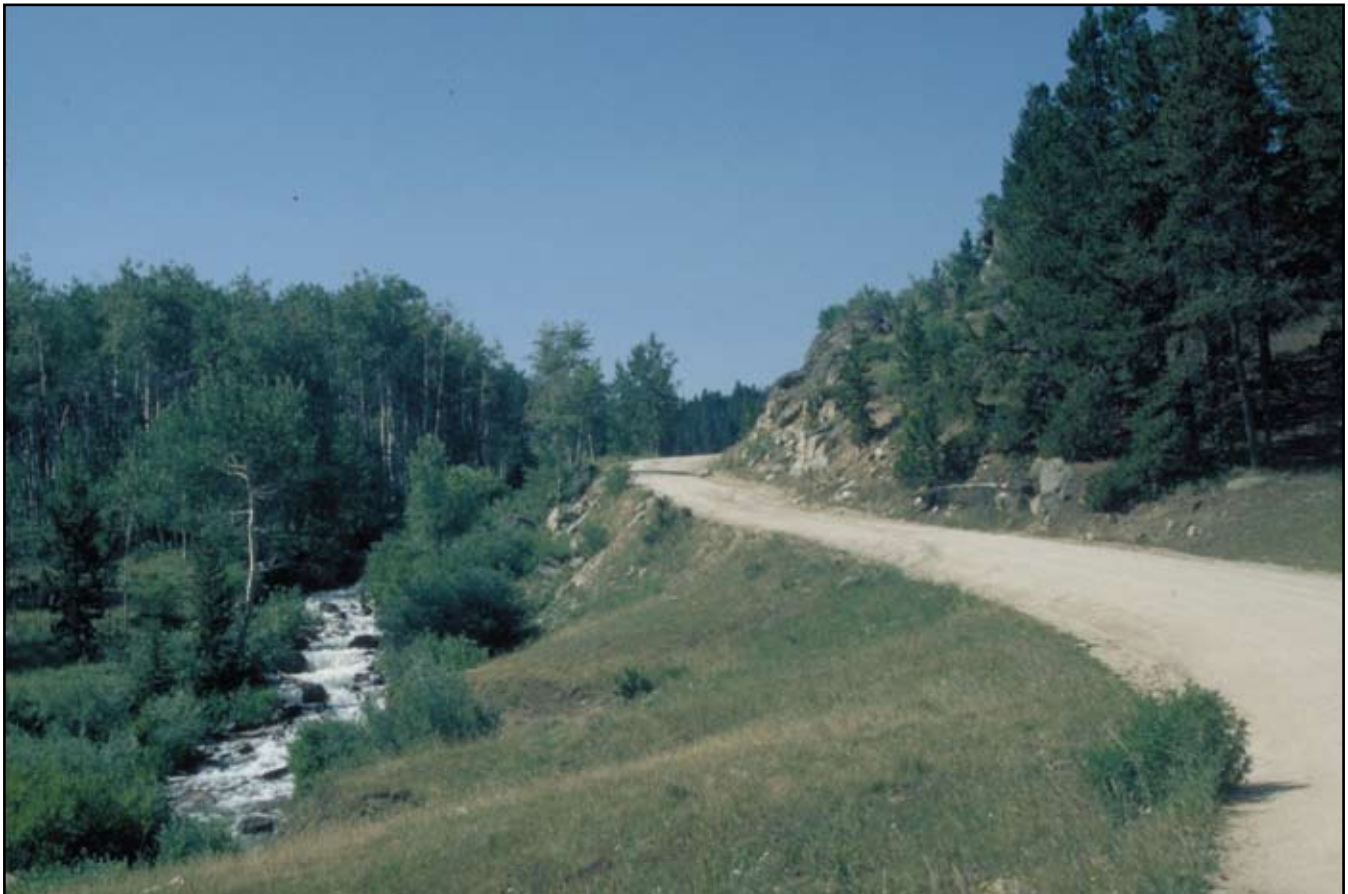
Foto 3.9 Ubicar los caminos y senderos de arrastre furera de los ríos y lagos. Este camino está demasiado cerca del río. Los sedimentos producidos en el camino llegarán al río.
