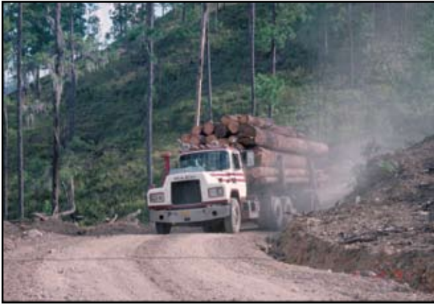
Foto 4.5 Camino estable para acarreo de troncos con superficie de agregados. Use materiales para revestimiento de caminos tan frecuentemente como sea posible, para disminuir la erosión, mejorar el soporte estructural de la base del camino y el confort del conductor.
