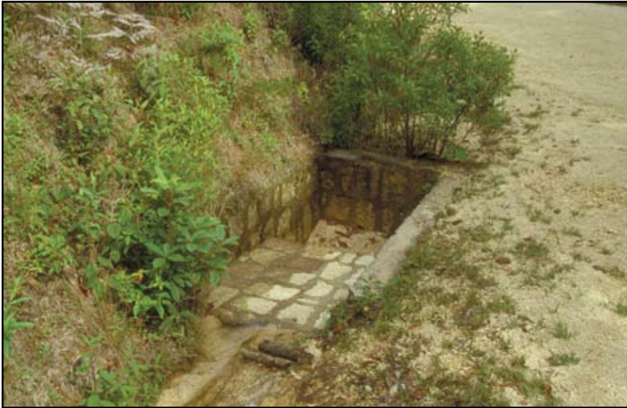
Foto 7.3 Use estructuras de entrada (o boca de caída) hechas de mampostería, concreto o metal para controlar el agua en la cuneta y encauzarla hacia el tubo de drenaje transversal y evitar la socavación de la cuneta.
