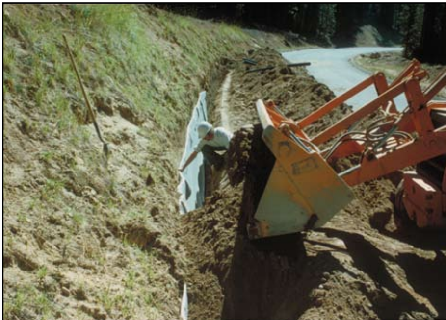
Foto 6.4 Uso de geotextiles colocados encima de suelos finos para proporcionar una filtración adecuada a un subdrén geocompósito.
