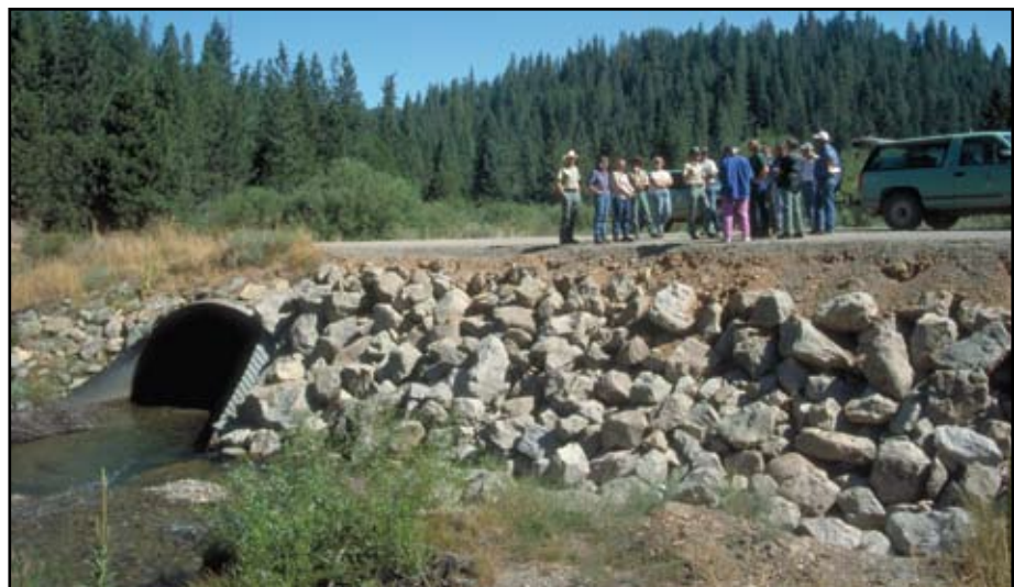
Foto 8.4 Alcantarilla tipo arco con placa estructural, con protección de las márgenes del arroyo a base de enrocamiento de gran tamaño, colocado sobre una capa de filtro de geotextil.
