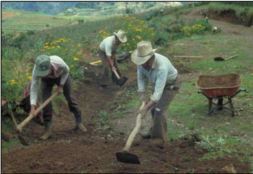
Foto 4.9 Realice el mantenimiento del camino, ya sea con equipo o a mano, para conservar la geometría de la calzada y el funcionamiento correcto de las estructuras de drenaje. Mantenga limpias las cunetas, pero no retire la capa de estabilización vegetal (pasto).
