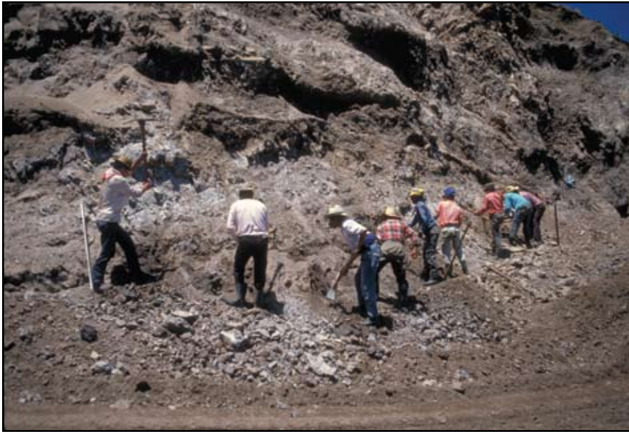
Foto 12.9 Explote canteras y bancos de préstamo (fuentes de abastecimiento de materiales) cercanos al sitio del proyecto, siempre que esto sea posible. Puede resultar adecuado hacerlo a mano o con máquinas, dependiendo de las condiciones del sitio y del ritmo de producción.
