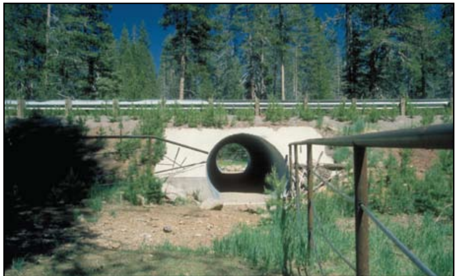
Foto 2.7 Una alcantarilla de paso inferior construida para permitir que los animales se desplacen con seguridad entre ambos lados del camino.
