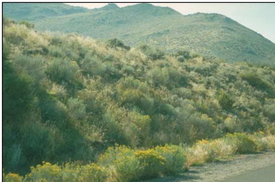
Foto 11.3 Talud de corte perfectamente estable, con una pendiente aproximada de 1:1 y bien protegido con vegetación.
