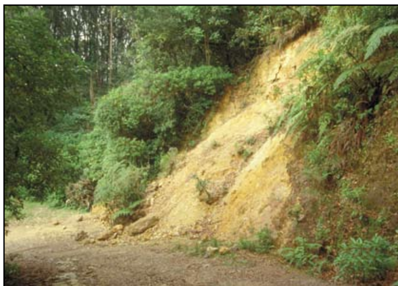
Foto 11.1 Tanto laderas muy abruptas, como zonas húmedas o de deslizamientos, pueden dar lugar a problemas de inestabilidad de los cortes de un camino y aumentar los costos de reparación y mantenimiento.
