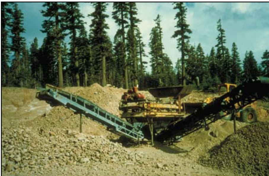
Foto 12.10 Las canteras y bancos de préstamo pueden proporcionar un recurso excelente y relativamente barato como fuente de materiales para el proyecto. Un sitio de explotación puede sólo necesitar una excavación simple, cribado o triturado, para producir los materiales necesarios. Controle el uso de la zona con un Plan de Desarrollo de Bancos.
