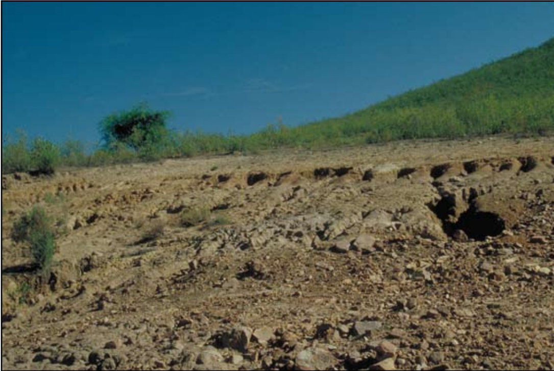
Foto 12.11 Esta zona de préstamo al lado del camino carece de control de drenaje y de la erosión. El desarrollo de bancos a un lado del camino puede resultar económico y útil, pero las áreas deben esconderse si es posible, y la zona deber rehabilitarse una vez concluido el proyecto.
