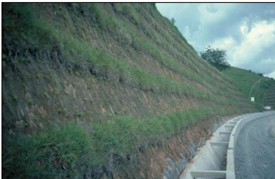
Foto 13.10 Uso de pastos, plantados en hileras, para proporcionar estabilidad a la superficie del talud y control de la erosión en cortes escarpados del camino.
