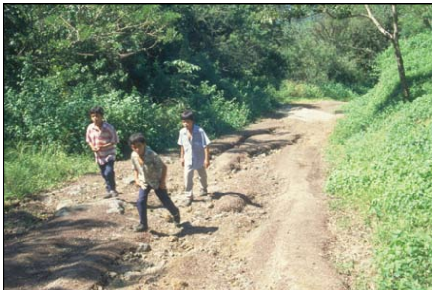
Foto 2.4 Impacto ambiental adverso producido por la erosión de la superficie del camino, derivada de pendientes fuertes y de drenes transversales inadecuados. El mantenimiento de este camino también se vuelve difícil.
