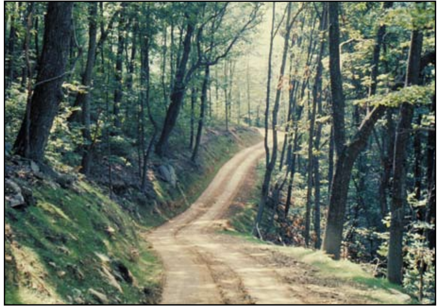
Foto 4.2 Localice los caminos de tal manera que se adapten a la configuración del terreno natural y deje ondulaciones que permitan dispersar el agua frecuentemente.
