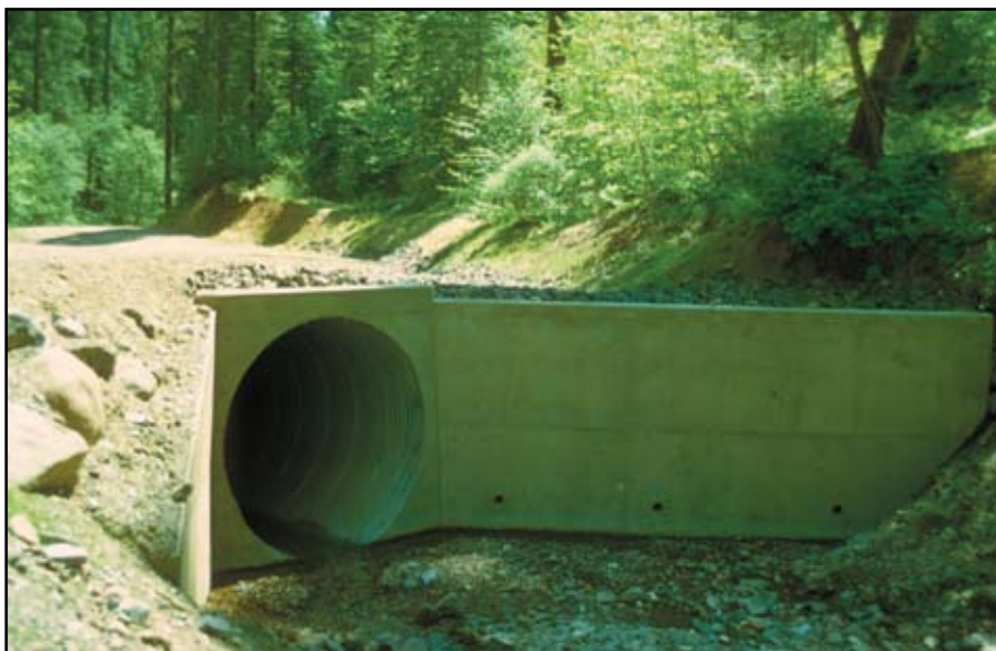
Foto 8.8 Instale alcantarillas con capacidad suficiente y con muros de cabeza para mejorar la capacidad de la alcantarilla, proteger el relleno de la calzada y evitar la socavación de las márgenes, sobre todo en un meandro o curva del canal.
