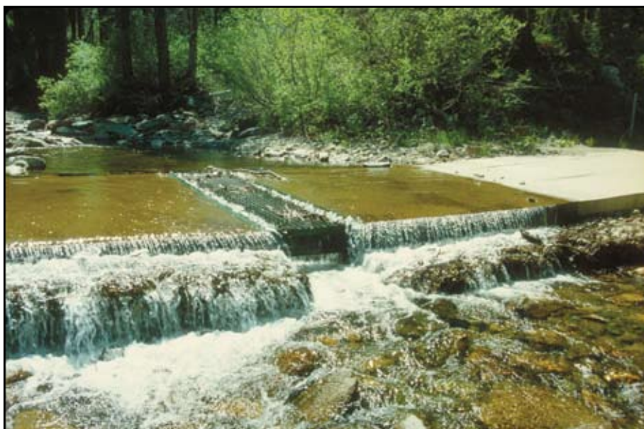
Foto 9.4 Vado mejorado con una abertura de cajón de concreto para pasar los flujos en estiaje, para mantener el tránsito fuera del agua la mayor parte del tiempo, minimizar los retrasos en el tránsito y para permitir el paso de peces.
