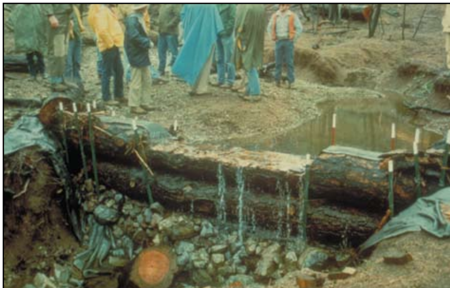
Foto 14.2 Uso de troncos para crear estructuras de estabilización de quebradas en una área afectada por incendios. Presas físicas o vegetales (diques o estructuras de retención de sedimentos) pueden ser usadas para controlar los sedimentos y estabilizar las quebradas. Evite la concentración de agua, antes de que se formen las quebradas.
