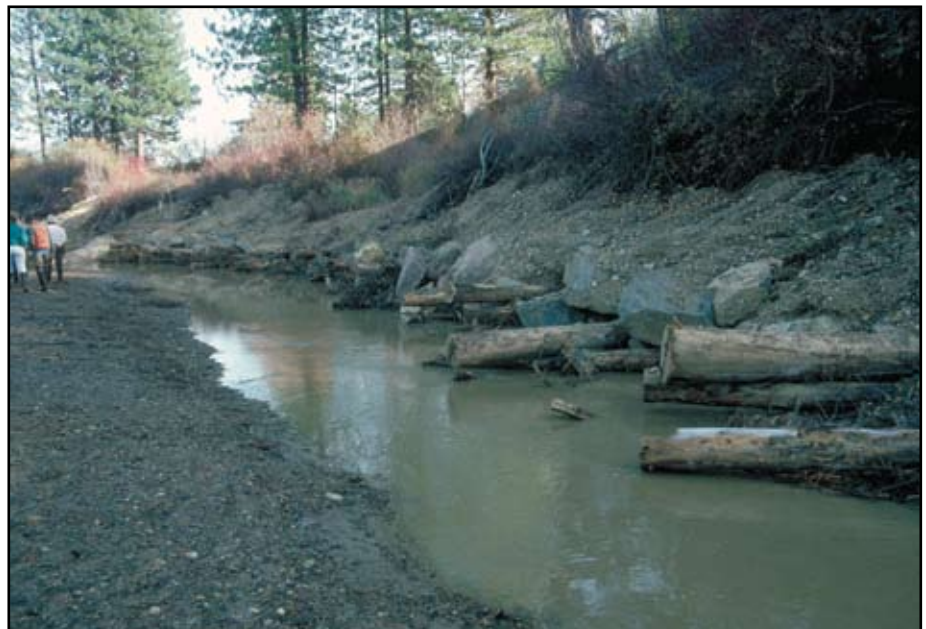
Foto 6.3 Un fajo de raíces, troncos y márgenes del arroyo protegidas con enrocamiento, se usan como protección contra la socavación. Los troncos y vegetación pueden brindar una alternativa atractiva al enrocamiento en zonas del arroyo con velocidades relativamente bajas.
