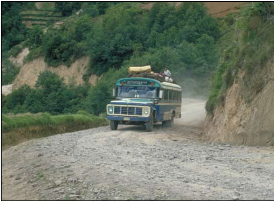
Foto 3.1 Camino local con bajo volumen de tránsito que produce un mínimo impacto negativo en el medio ambiente y que da servicio a los usuarios locales al proporcionar un enlace entre comunidades.
