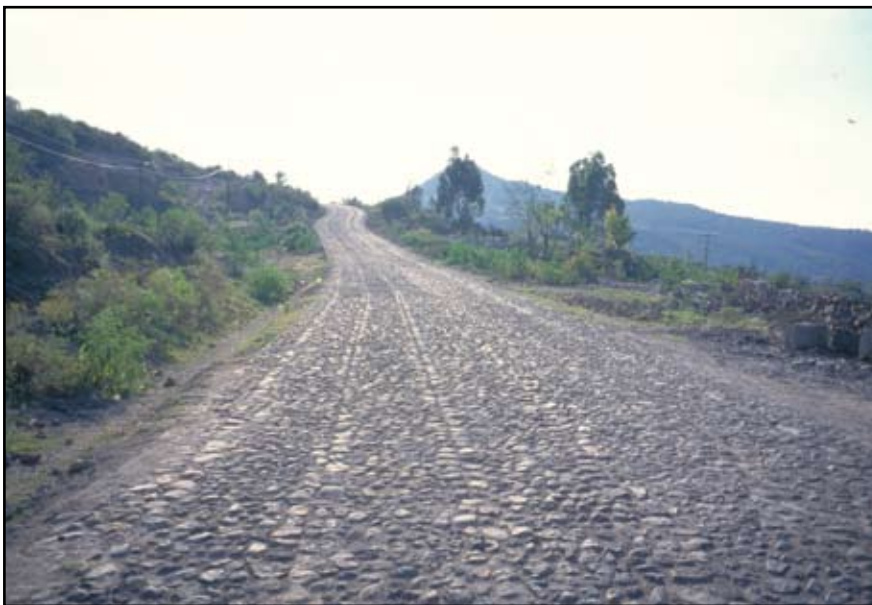
Foto 1.4 Camino bien diseñado de “impacto mínimo” que tiene una especificación adecuada para su uso, así como una superficie de rodadura (empedrado) estabilizada.
