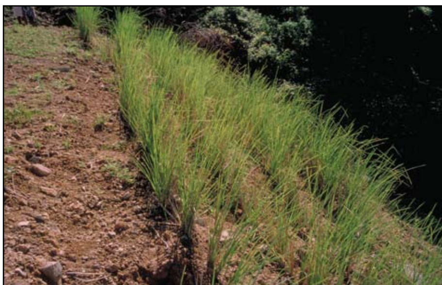
Foto 13.9 Uso de pasto Vetiver para estabilización de taludes y control de la erosión. Seleccione vegetación que se adapte al sitio, que tenga raíces fuertes, y que proporcione una buena cobertura del terreno. De preferencia usar especies nativas.
