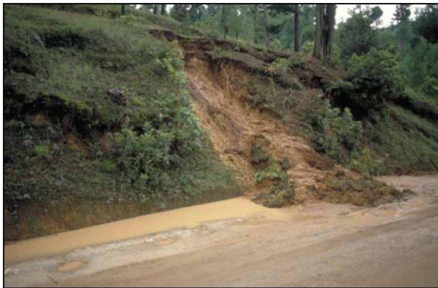
Foto 4.11 Retire el material de los deslizamientos que bloqueen las cunetas de drenaje y que reduzcan el ancho del camino.
