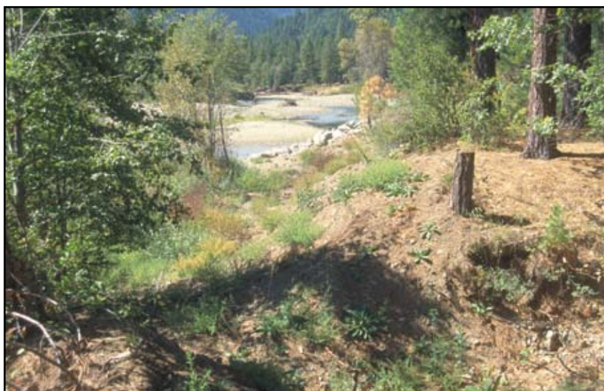
Foto 4.12 Cierre los caminos que ya no se necesitan o que se usaron para acceso temporal. Estabilice la superficie con caballones desviadores, bermas y con cobertura vegetal.
