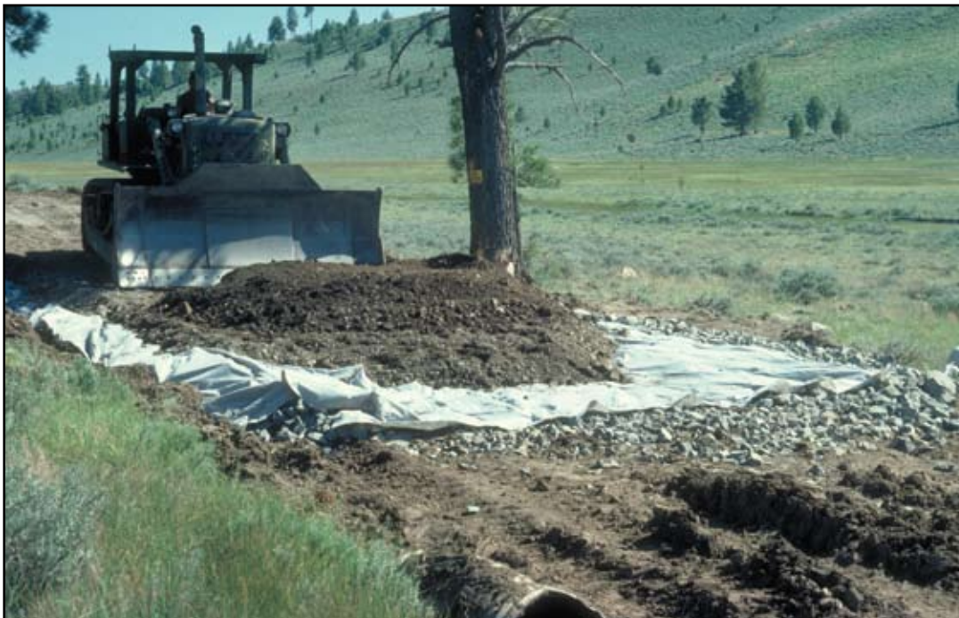
Foto 7.10 Utilice subdrenes o capas de filtro permeables cuando sea necesario, para eliminar el agua de la subrasante del camino en zonas de humedales o de manantiales.
