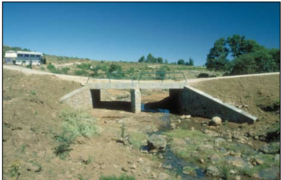
Foto 8.3 Instale alcantarillas de mampostería, de cajones de concreto o de metal, con un tamaño (capacidad) lo suficientemente grande para pasar con seguridad el caudal o flujo de diseño anticipado, con escombros, de diseño anticipada (típicamente por un periodo de recurrencia de 20 a 50 años), con base en un análisis hidrológico. Use muros de cabeza o de alero siempre que sea posible.
