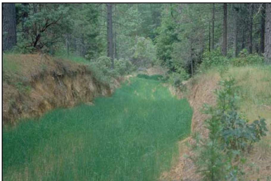
Foto 13.8 Semillas y cubierta vegetal (capas para protección de semillas y para retención de la humedad) aplicados a la superficie del terreno natural, para promover el crecimiento de pasto sobre zonas desgastadas, caminos cerrados y en suelos erosionables.
