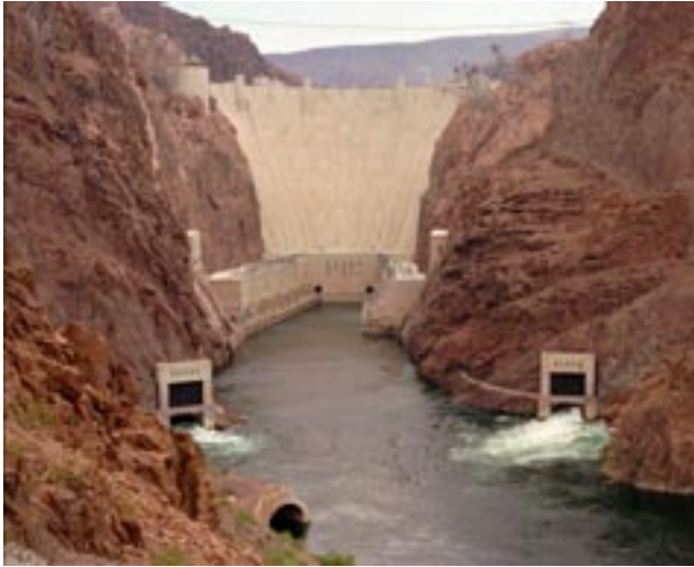
La presa Hoover, cerca de la ciudad de Boulder, Colorado, tiene 221 metros de altura y 379 de longitud, y está construida en el río Colorado, entre Nevada y Arizona. La presa, que lleva el nombre del presidente Herbert Hoover, es una importante fuente de energía hidroeléctrica y suministra agua de riego a más de 425.000 hectáreas de terreno en Estados Unidos y México.
