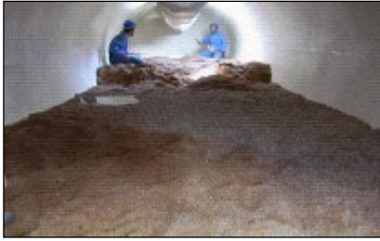
عمال يقومون بوضع طبقة الرمل في المرشح الرملي في مشروع معالجة المياه في بغداد .
