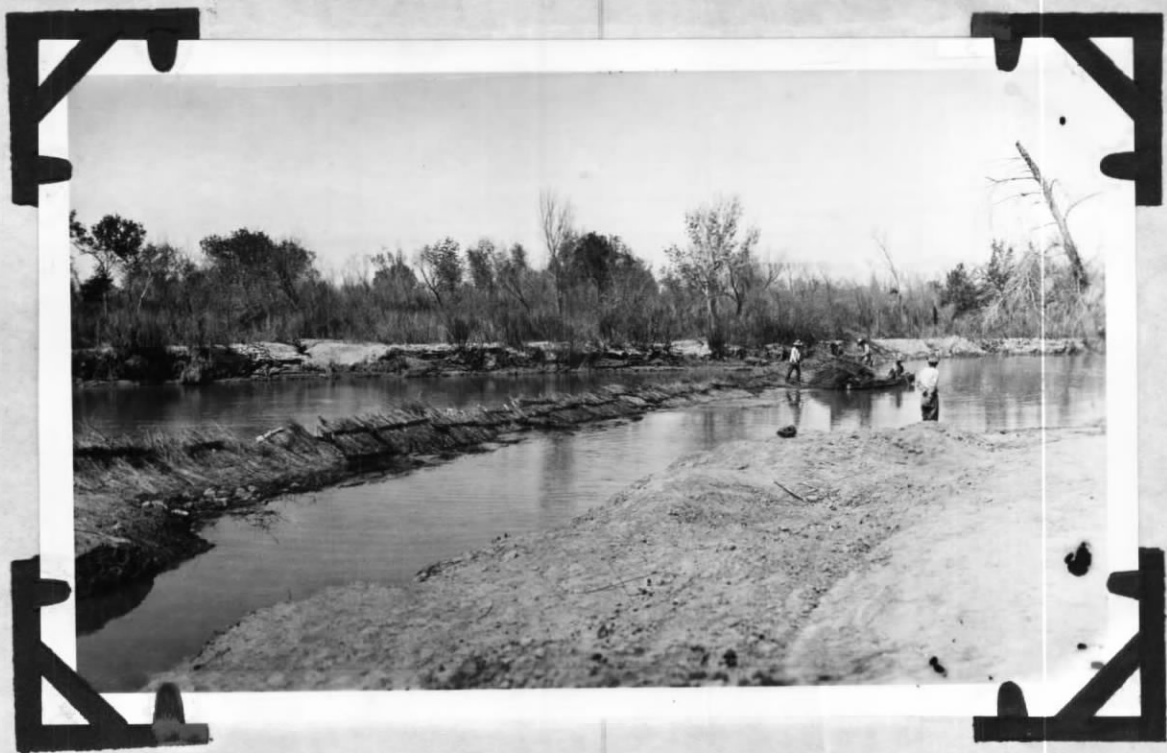
Río Bravo.- Presa de derivación en La Haciendita, Texas.
