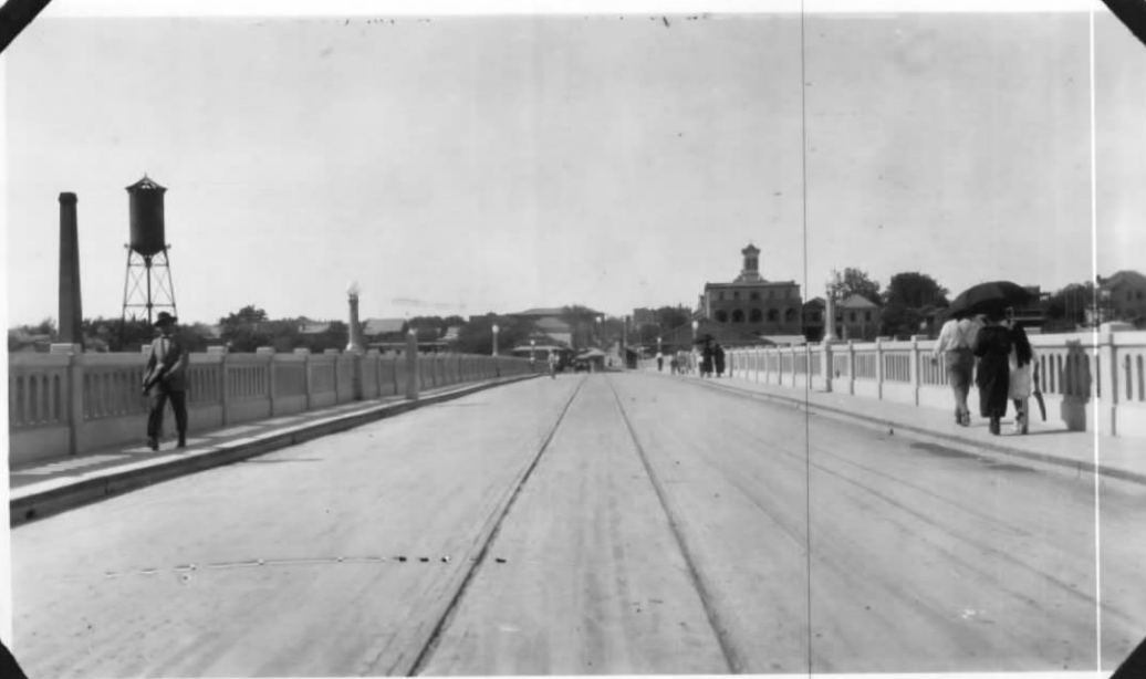
B.- Río Bravo.- Puente internacional entre Laredo, Texas, y Nuevo Laredo, Tamaulipas.- Posición del monumento.-
