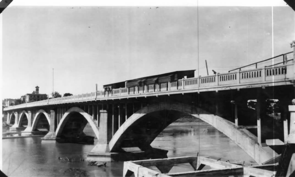
A.- Río Bravo.- Puente internacional entre Laredo, Texas, y Nuevo Laredo, Tamaulipas.- Localización del monumento que marca la línea divisoria internacional.-
