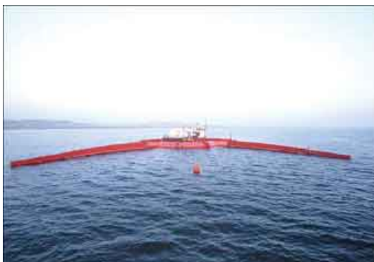
Overtopping (Wave Dragon)
